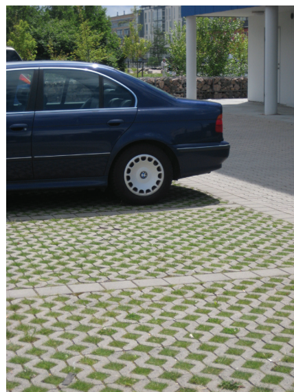
Figur 35: Permeabel græsarmering på parkeringsplads i boligområdet B001 i Malmøs Västra Hamn. Græsarmering sikrer både nedsivning og fordampning af regnvand. Foto Orbicon
